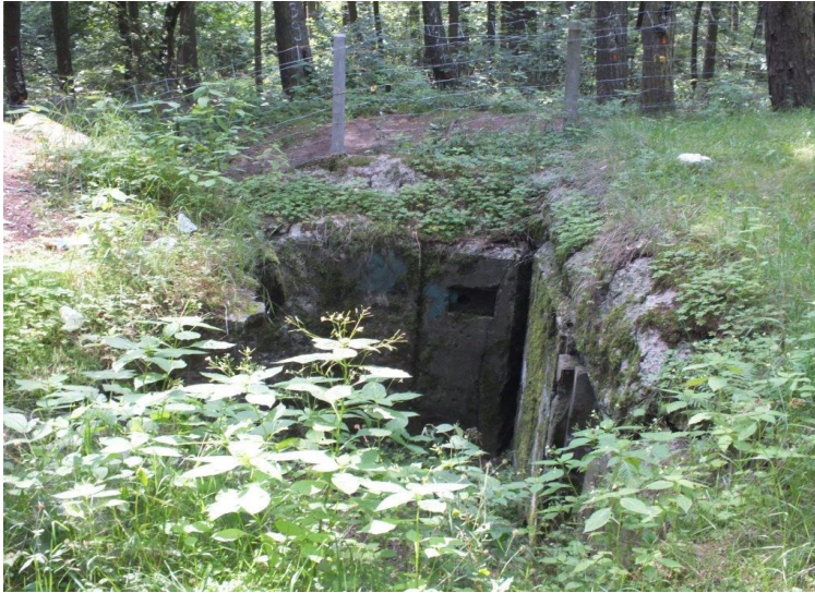
Fot. 4 Bunkier – element fortyfikacji Wału Pomorskiego
