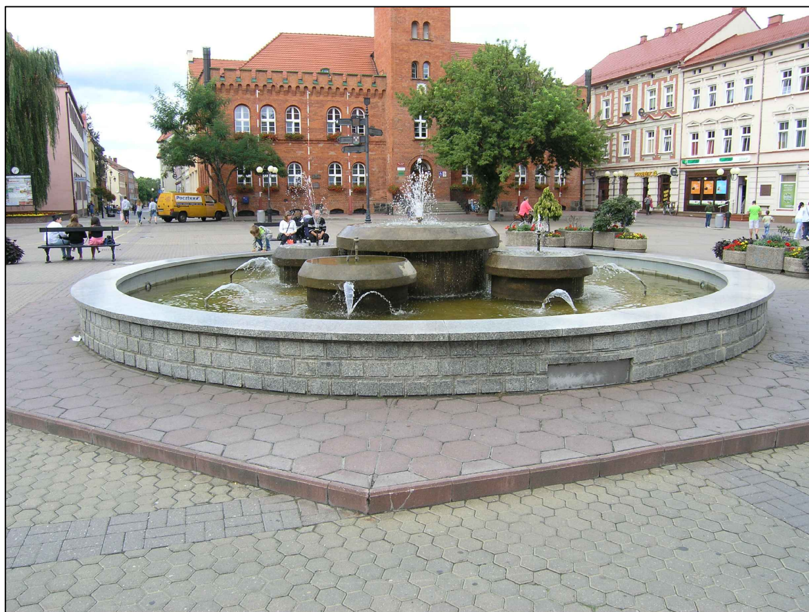
WIDOK ISTNIEJĄCEJ FONTANNY PRZEZNACZONEJ DO ROZBIÓRKI
