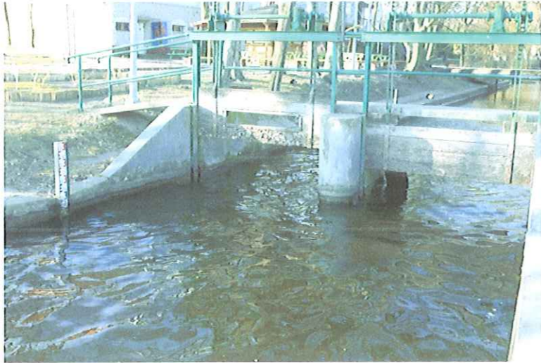
Ryc. 1. Urządzenie regulujące poziom wody w jeziorze, odpływ z Jeziora Trzesiocko
