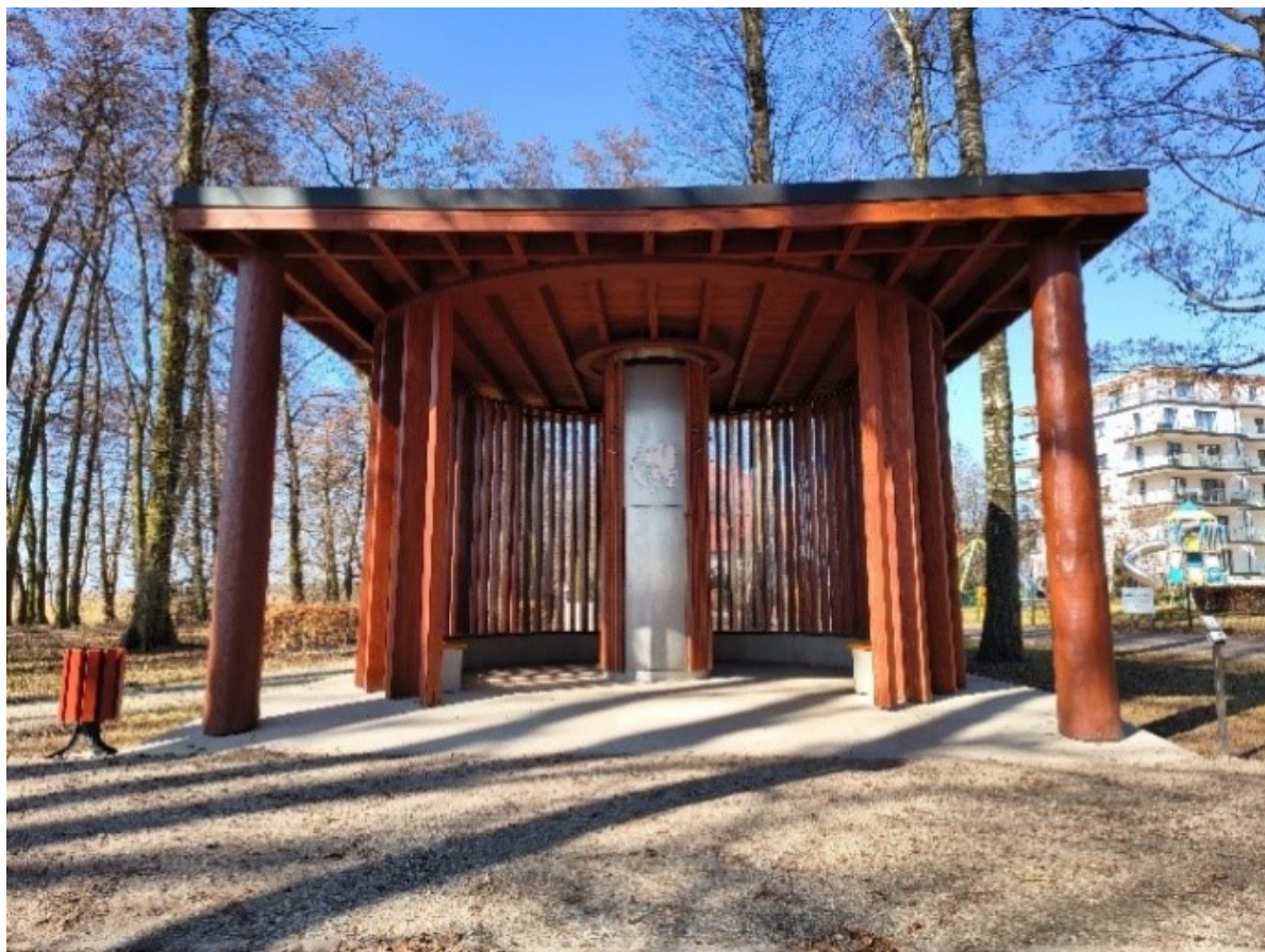
Zdjęcie 9. Budowa tężni solankowej w Parku Miejskim w Szczecinku – po realizacji
